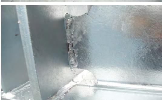
溶接箇所の防錆とそう不良箇所があるのでスプレー処理をするよう指示しました。
