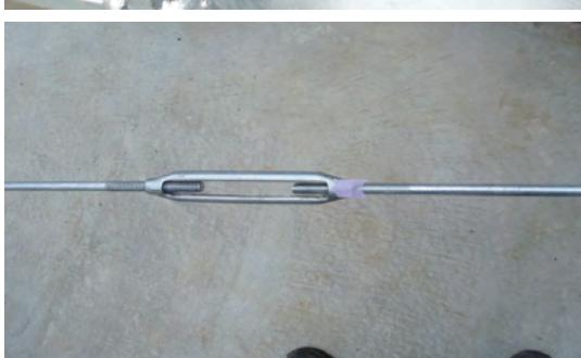
水平ブレースのターンバックルの締め忘れが1箇所あるのでその場で締め付けをさせました。
