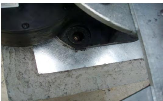
ダンパー装置のボルトが1本欠損したので新しいボルトにて固定をすることとなります。
